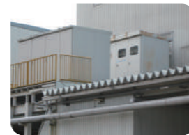
Máy biến áp dầu nhận được đặt cách xa mặt đất để tránh bị mất điện
