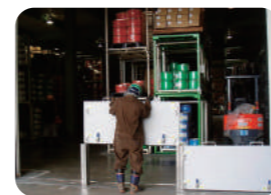
Địa chống thủy triều được lắp đặt để bảo vệ nguồn hàng khỏi bị hư hại do nước
