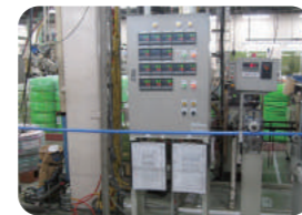
Thiết bị kiểm soát được đặt cách xa mặt đất để xử lý rò rỉ
